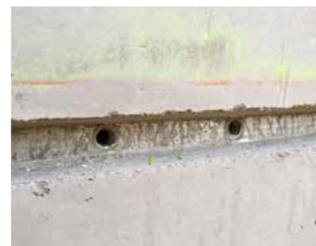
MODIX® standard muffe indstøbt i reces.
