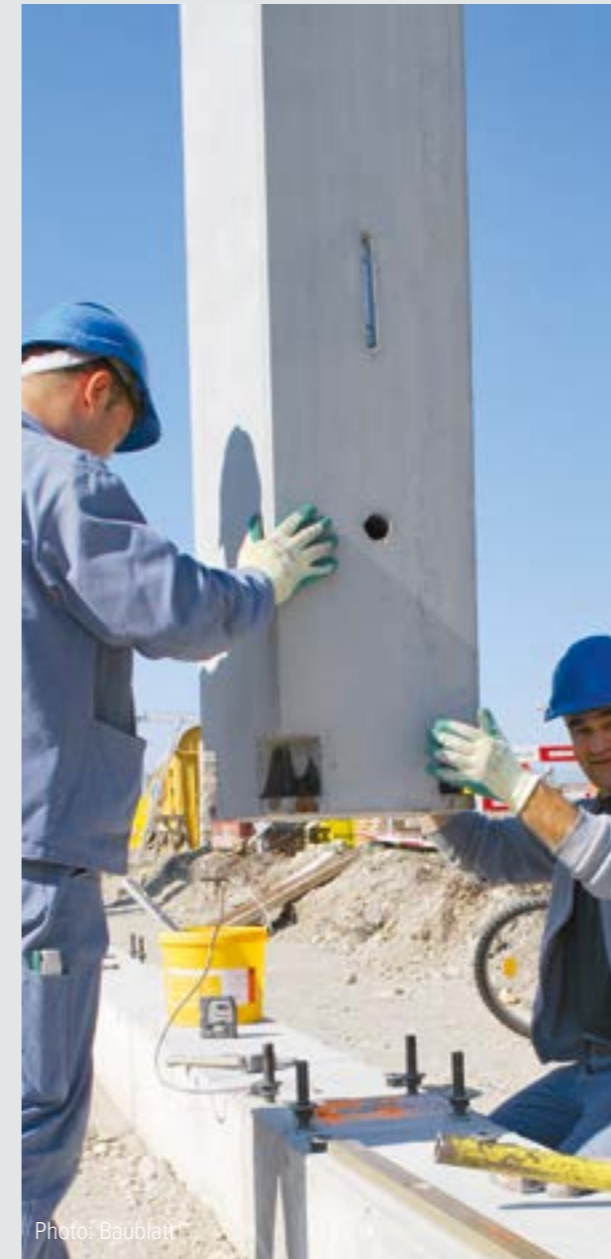
Bilder: Montage der Peikko Stützenverbindung aus Stützenschuhen und Ankerbolzen
