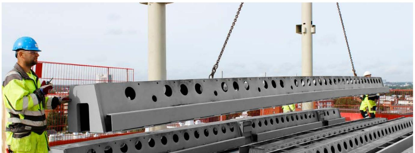
**HINWEIS:** VERWENDEN SIE NUR GEPRÜFTE HEBEZEUGE UND VERRIEGELN SIE DIE ANSCHLAGMITTEL. ES DÜRFEN KEINE HEBEGURTE/-KETTEN UM DEN DELTABEAM® GELEGT ODER DURCH DIE STEGÖFFNUNGEN GEFÜHRT WERDEN! SICHERHEITSRISIKO!
