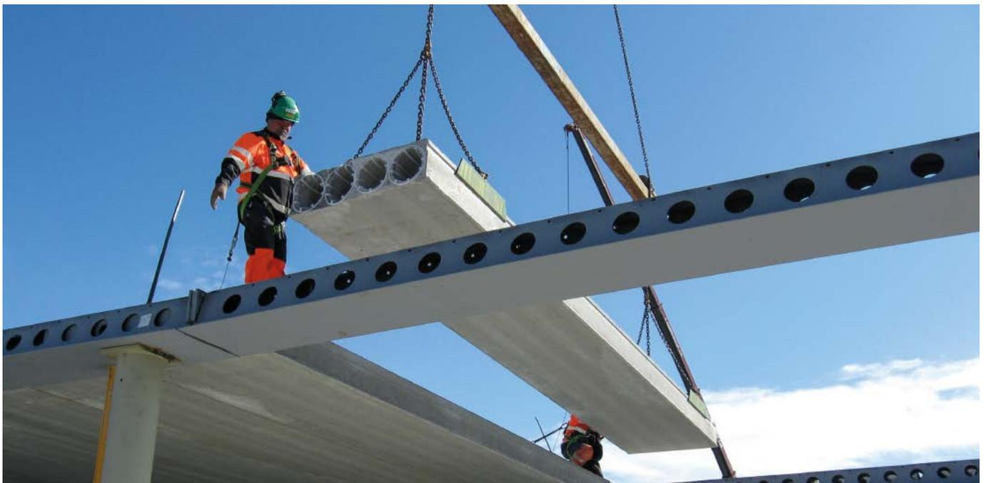
An Spannbeton-Hohlplatten müssen Ausnehmungen des oberen Plattenspiegels zur Einbringung der Querbewehrung im vorgegebenen Abstand vorgesehen werden. Nach Vorgabe des Deckenherstellers werden bei Bedarf Elastomerlager-Streifen auf die auskragenden Untergurtflansche außenseitig bündig aufgelegt. Andere Deckenelemente werden in der Regel direkt auf dem Stahl-Untergurt aufgelegt und der maximale Abstand zwischen dem DELTABEAM® Steg und Deckenelement ist 30 mm.
