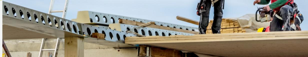
**DELTABEAM® Verbundkonstruktionen ermöglichen die Kombination des erneuerbaren und ökologischen Baustoffs Holz mit den widerstandsfähigen Materialien Stahl und Beton. DELTABEAM® ist eine hervorragende Lösung für Slim-Floor Konstruktionen im Holz-Beton-Verbundbau.**
